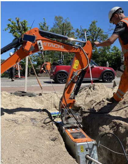
Nano-Drill in actie ( https://www.kouwenberginfra.nl/technieken/nano-drill/ )
